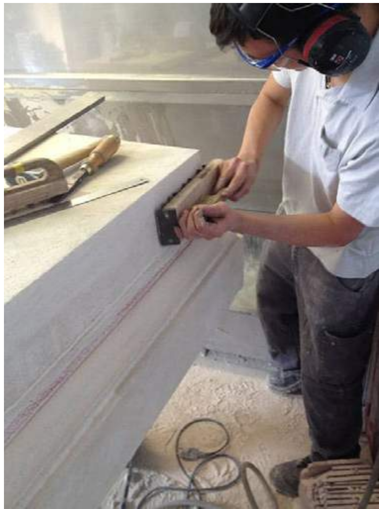
Entreprise Blanchon à Limoges, Haute-Vienne
