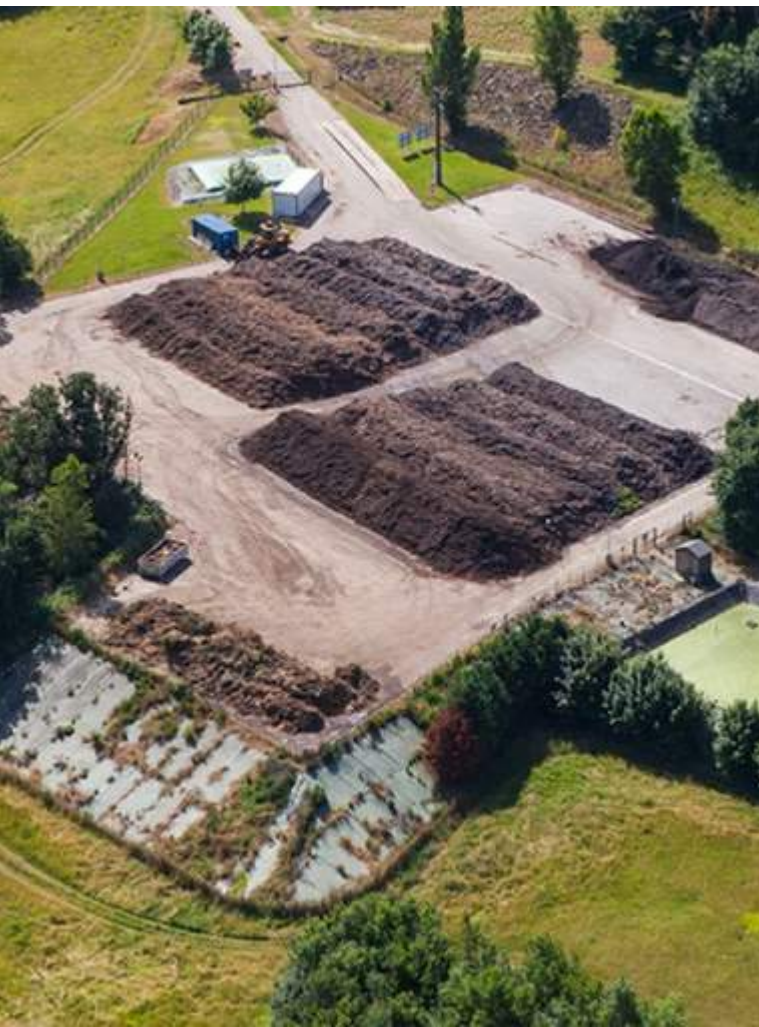
Plateforme de compostage d'Artigues, Lot-et-Garonne
